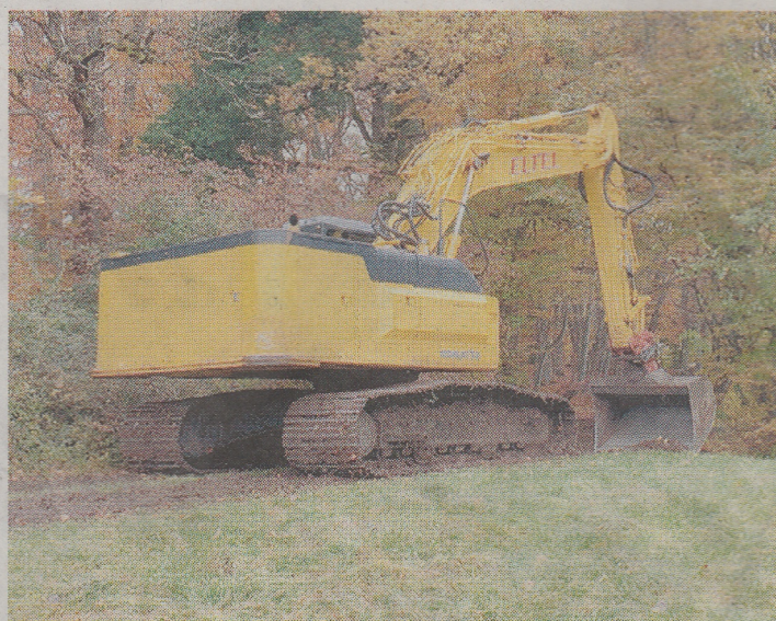
De grandes machines de chantier ont œuvré dans le Bois de Chênes la semaine dernière. PBU
