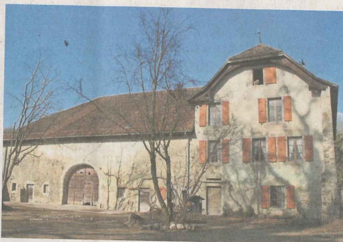
Les abords de la ferme ont été déboisés. YVES MERZ
